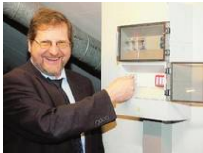
Bürgermeister Roland Krügel setzt die Anlage in Betrieb.
